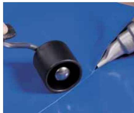
Oprava zvarov (Typ HG651C)
